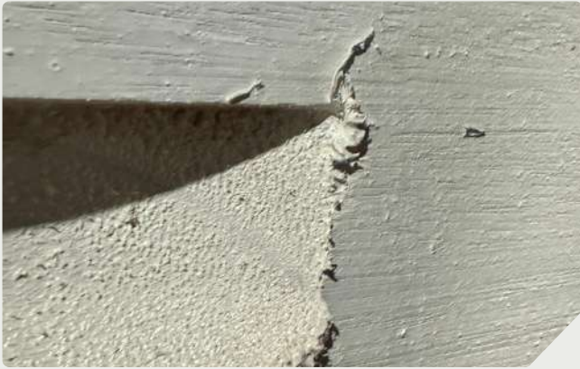
Detalle productivo de rebaba de madera en bajo relieve de la pared de la colmena, demuestra la baja atención a la terminación final.
