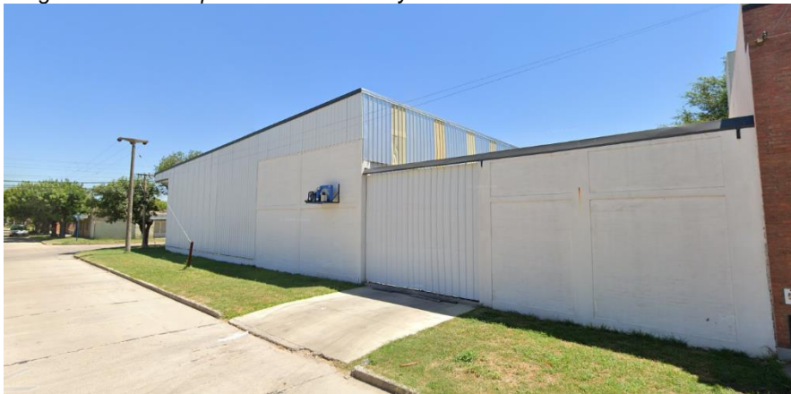
Imagen 8 "Lateral deposito "número dos" y la entrada/salida de camiones"
